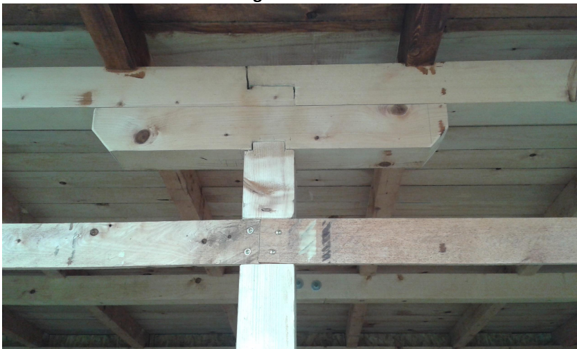
Abb. 29: Zimmermannverbindungen
